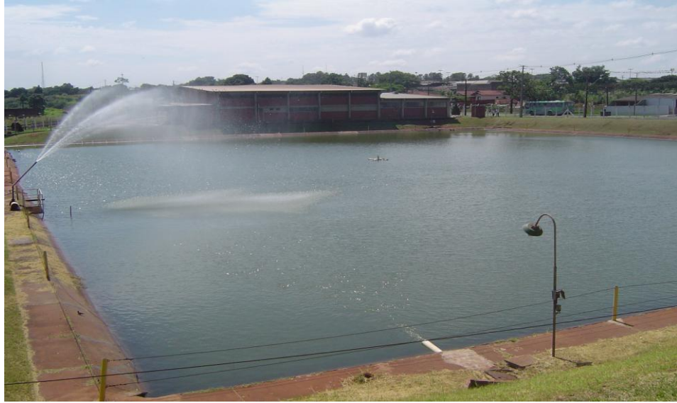
Figura 7: Lagoa de Estabilização III
