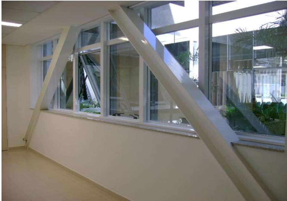
Figura 14: Sistema de contraventamento com perfil metálico aparente
