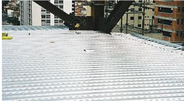
Figura 9: Detalhe da laje Steel Deck
