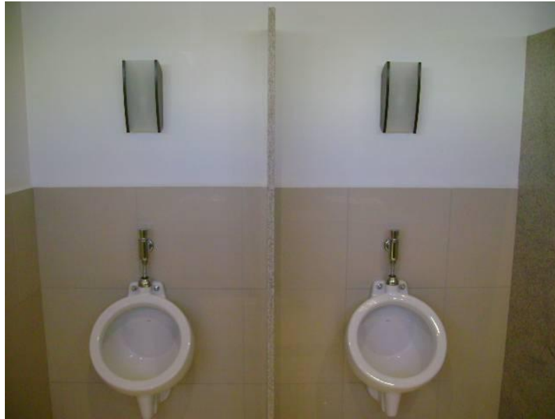
Figura 17: Revestimento aplicado sob a parede de Dry Wall
