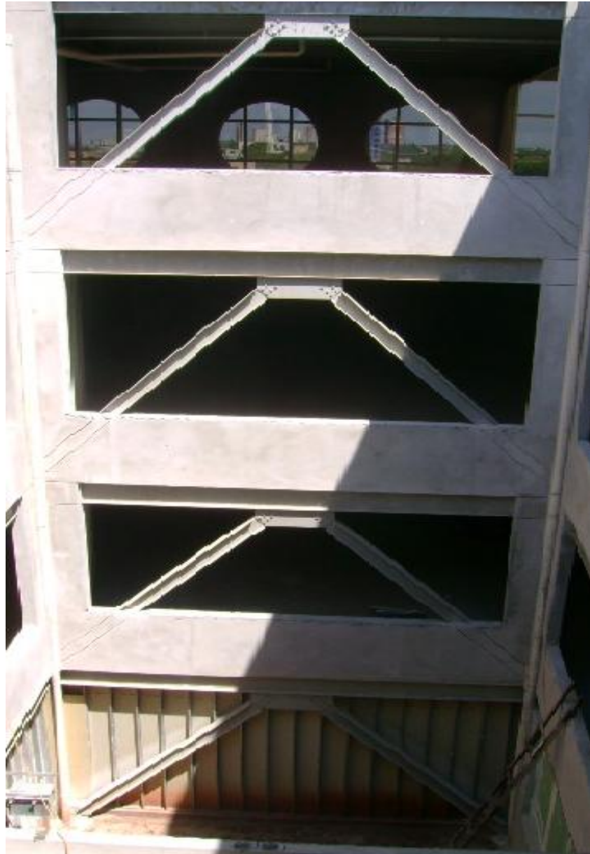
Figura 13: Sistema de contraventamento
