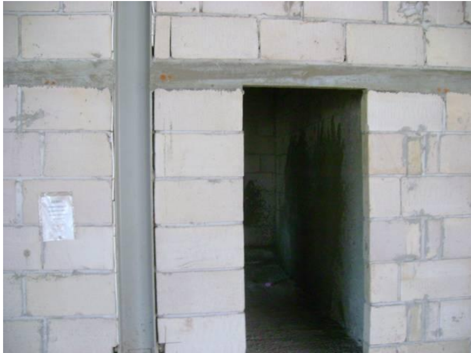
Figura 15: Fechamento lateral com bloco celular
