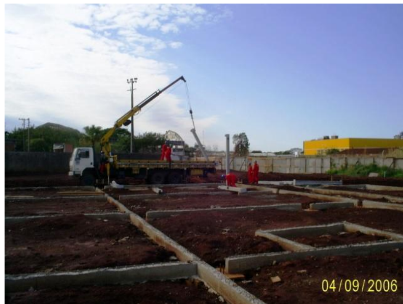
Figura 10: Início da montagem da estrutura
