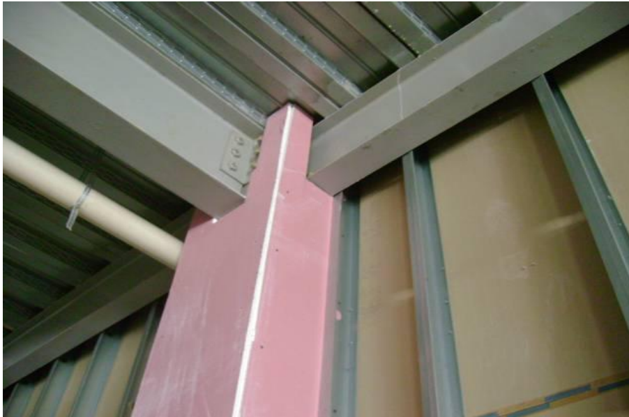
Figura 12: Foto da proteção contra incêndio dos pilares com placas de gesso acartonado resistente ao fogo
