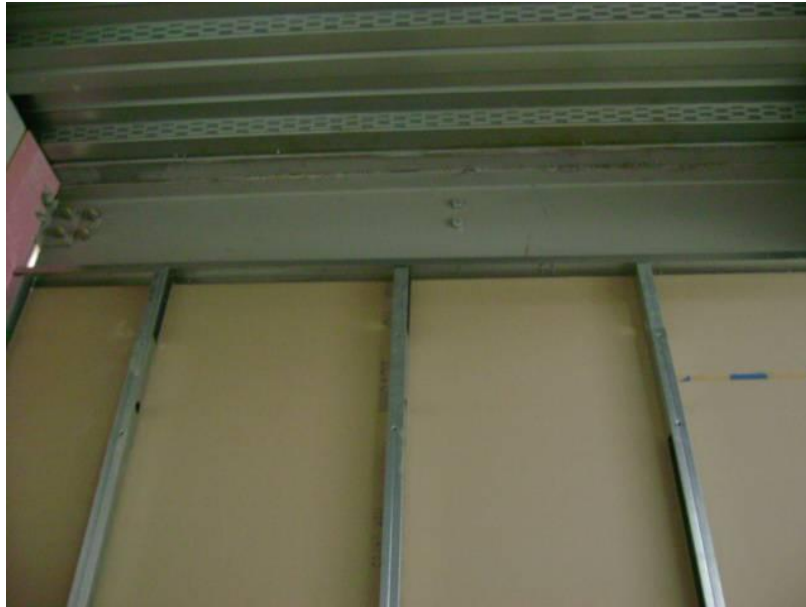
Figura 22: Ligação entre o perfil metálico e a viga Fonte. COELHO, 2009
