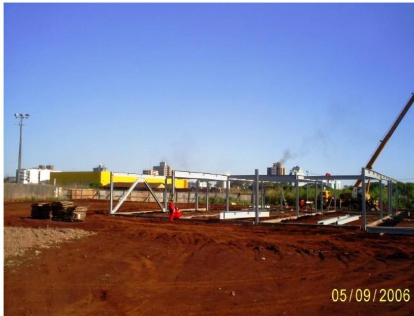
Figura 11: Segundo dia da montagem
