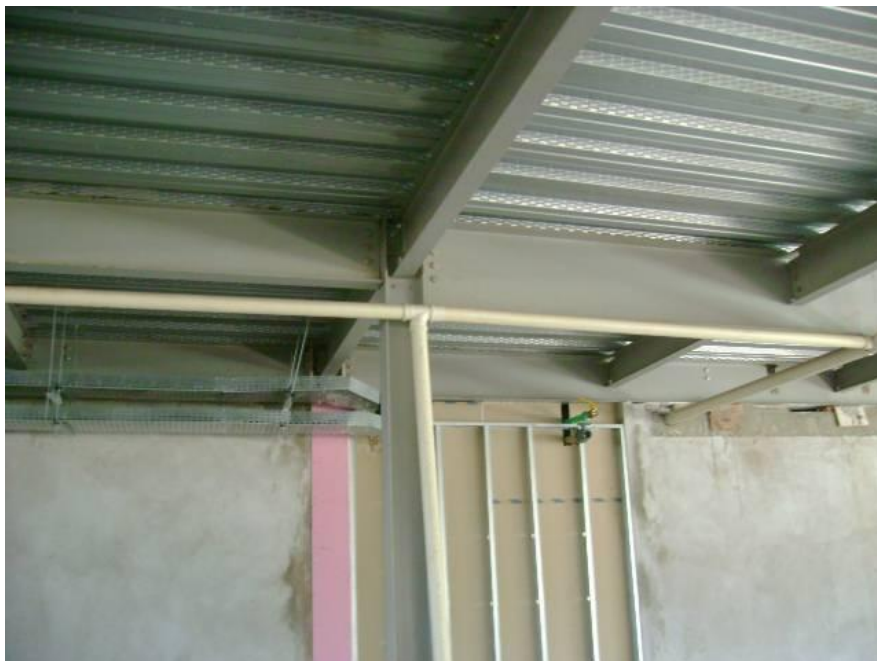
Figura 19: Passagem das tubulações
