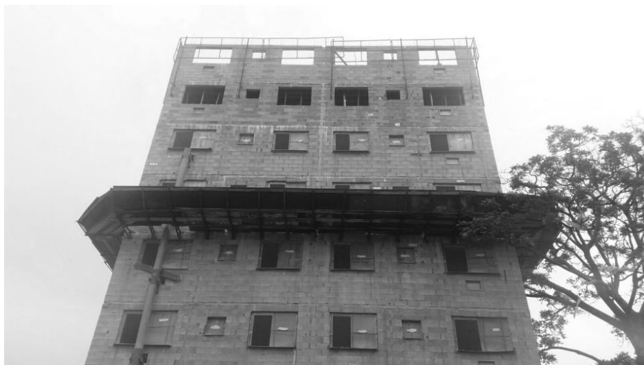
Figura 07 – Foto geral da obra para observação da fase de acabamento de alvenaria do Canteiro de Obras 2
