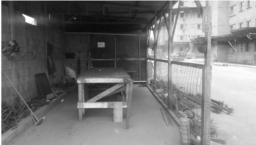
Figura 10 – Central de Armação do Canteiro de Obras 2
