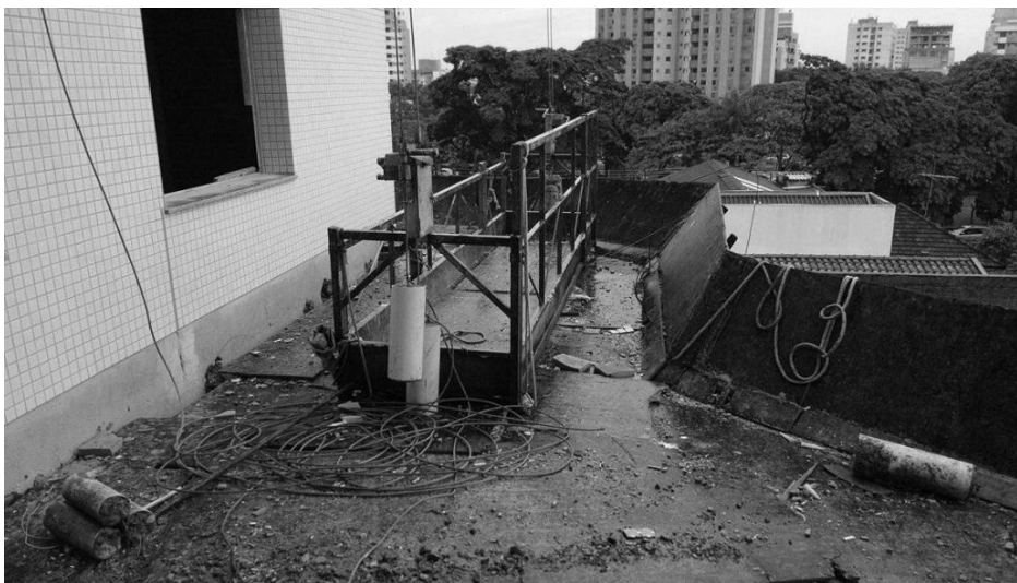
Figura 16 – Plataforma de proteção principal e andaime suspenso no canteiro de obras 3
