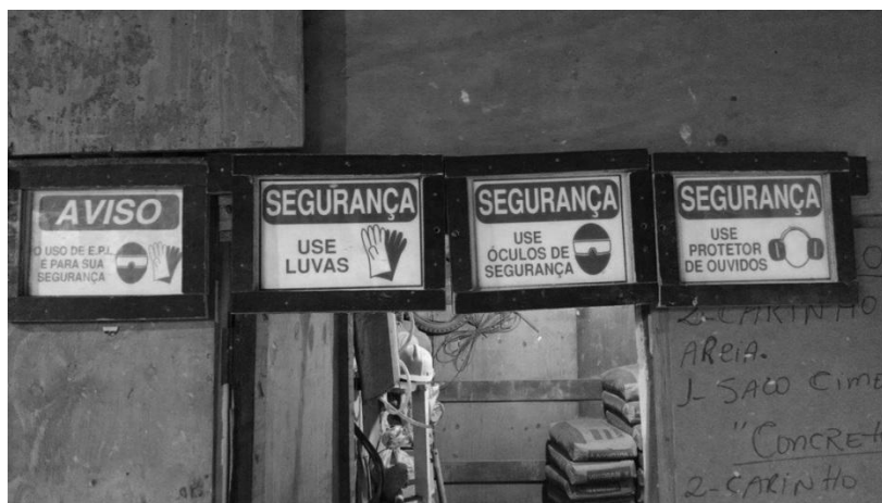
Figura 18 – Sinalizações de Segurança no canteiro de obras 3
