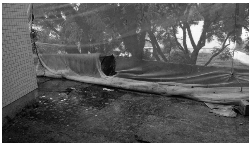
Figura 17 – Equipamento de Proteção Coletiva no canteiro de Obras 3
