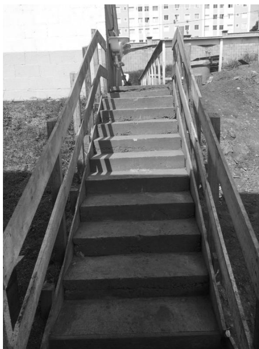
Figura 04 – Escada de acesso ao refeitório e vestiários do Canteiro de Obras 01
