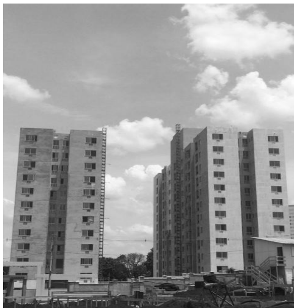
Figura 21 – Foto da parte externa do Canteiro de Obras 4
