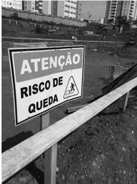
Figura 02 – Imagem de placa de sinalização de perigo no Canteiro de Obras 1
