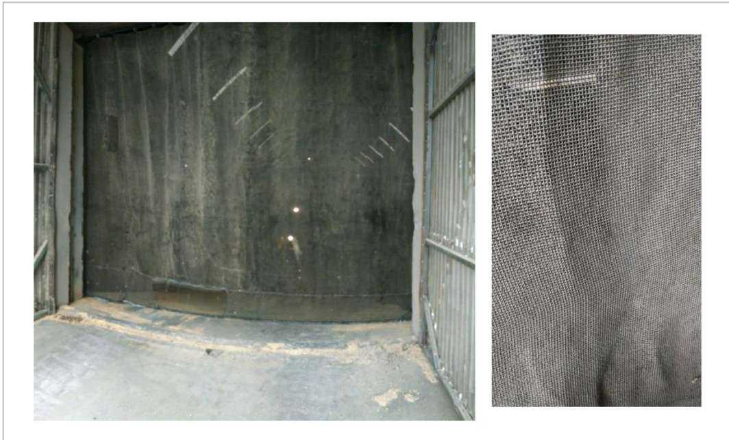
Figura 16 - Telas de proteção instaladas
