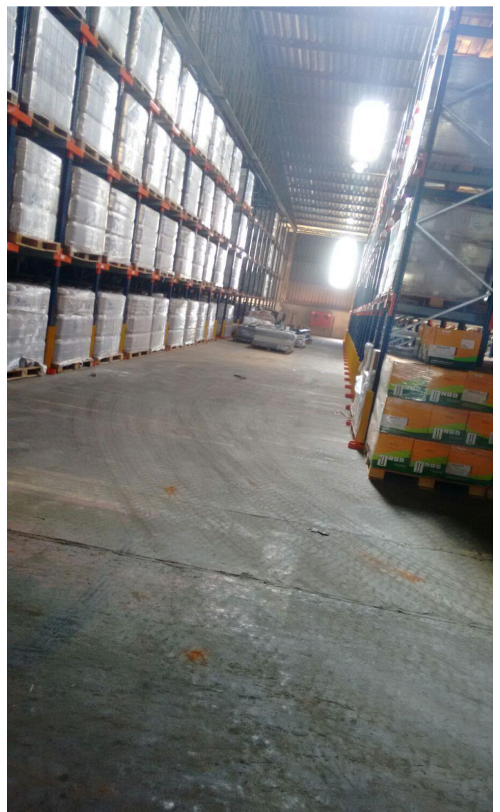
Figura 25 - Armazém depois da construção do Drive-in .
