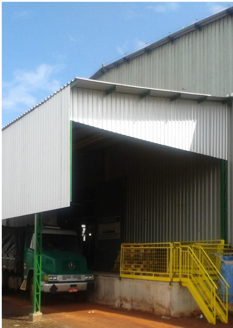
Figura 27 - Doca de carregamento depois da adequação.
