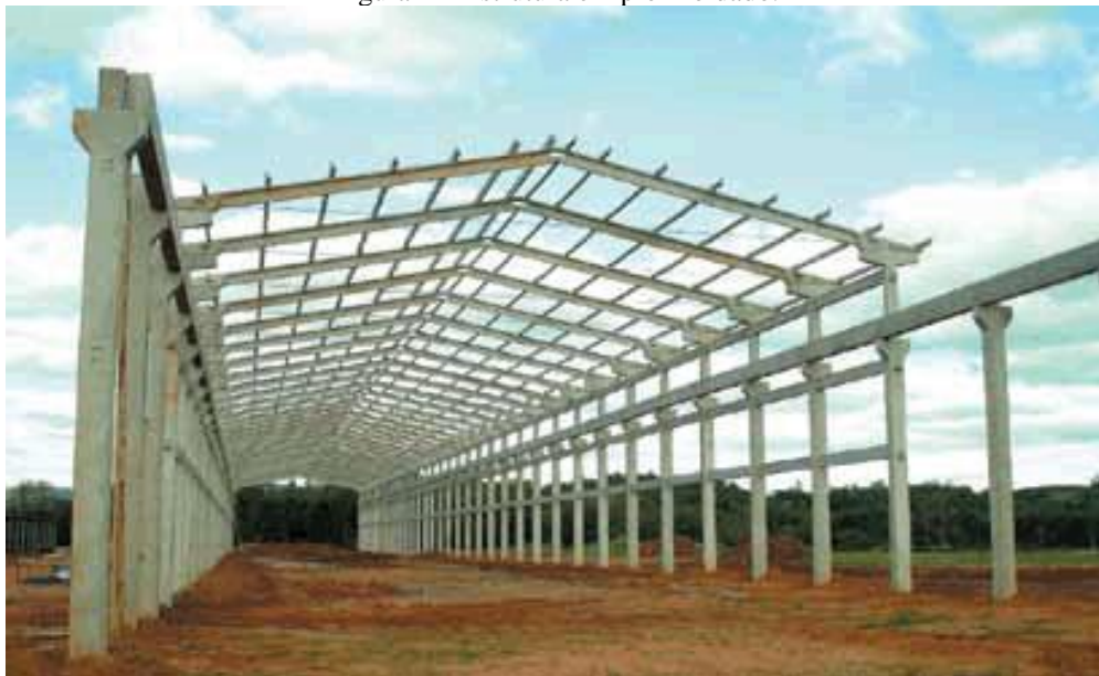
Figura 2 – Estrutura em pré-moldado.
